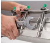
La llave con el soporte, actúa como efecto palanca: Con una mano sujetamos el soporte con la llave, y a la vez colocaremos el puente de apriete. Con la otra mano anclaremos la parte superior de la pieza, para efectuar el cierre de la abrazadera. Apretamos las tuercas y reparación finalizada.
